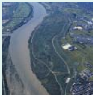
淀川流域・鶴殿のヨシ原調査
