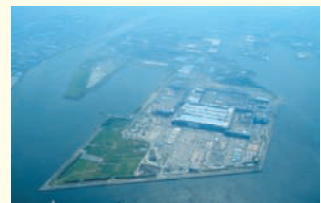
工場建設が進む堺泉北港・堺2区
