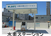
水素ステーション
