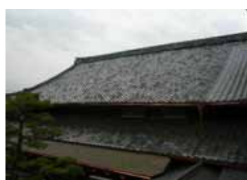
上七軒歌舞練場 （大屋根、下屋、樋等修理後）
