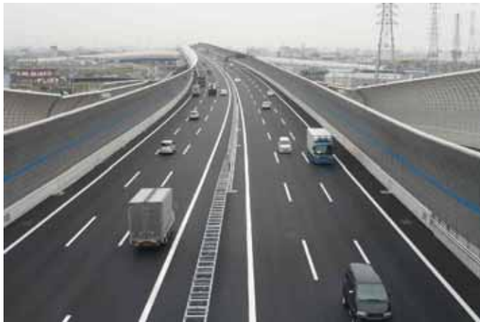
第二京阪道路（寝屋川市） 提供：近畿地方整備局
