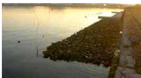
生物共生型護岸（堺泉北港堺 2 区北泊地）
