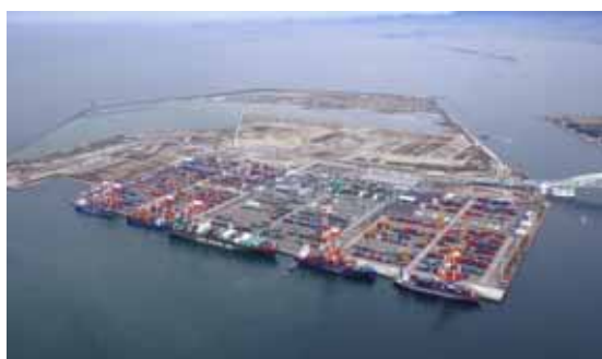
夢洲コンテナターミナル
