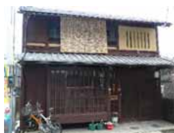
京町家を活用した民宿 （旧長岡家住宅） （屋根、外壁等修理後）
