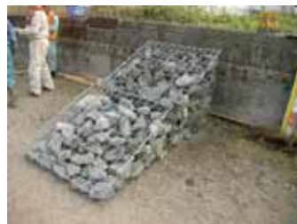
生物共生型護岸（魚礁ブロック型）
