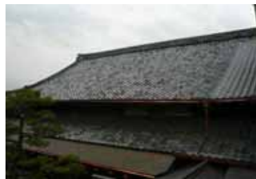
上七軒歌舞練場 （大屋根、下屋、樋等修理後） 提供：京都市
