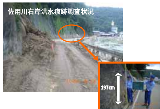
TEC-FORCE 隊員による現地調査 提供：近畿地方整備局
