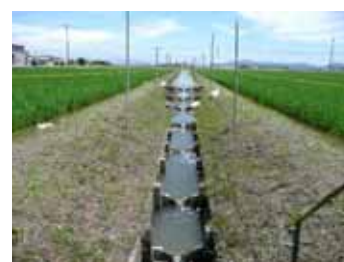
魚道設置による水田と排水路の落差解消
