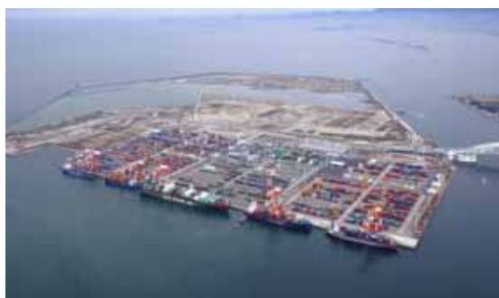
夢洲コンテナターミナル
