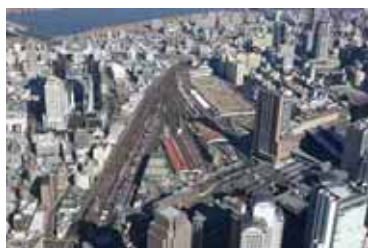
大阪駅北地区 提供：大阪市
