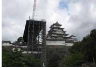
姫路城大天守保存修理 提供：姫路市
