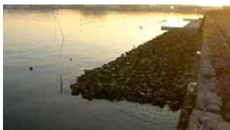
生物共生型護岸（堺泉北港堺2区北泊地）
