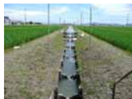
魚道設置による田んぼと水田の落差解消
