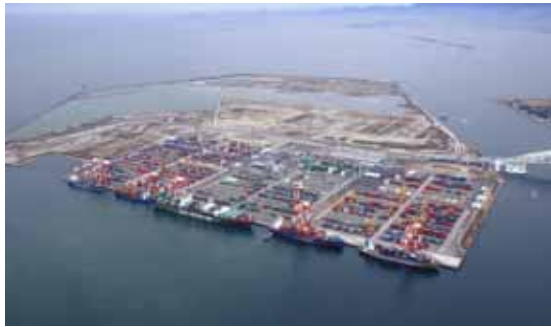
阪神港夢洲コンテナターミナル
