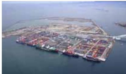
夢洲コンテナターミナル
