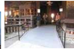
清水寺におけるバリアフリー化の取組 提供: 近畿地方整備局
