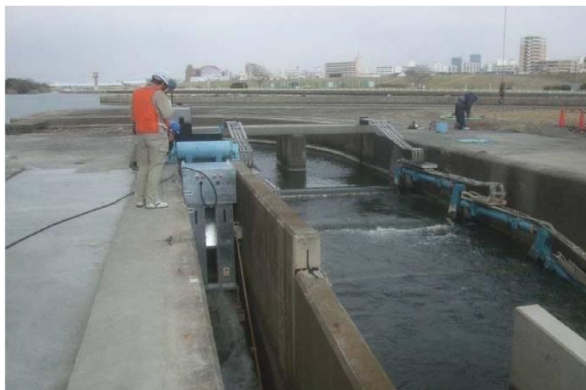
小水力発電設備
