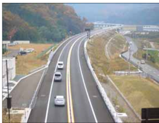
谷田部（やたべ）トンネル～南川（みなみがわ）橋 (小浜 IC (敦賀方向)) を望む (提供：NEXCO 西日本)
