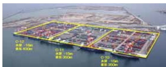
夢洲コンテナターミナル (C-10~12) (提供：大阪市)
