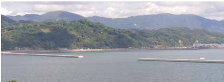
湯浅広港津波防波堤 (提供：和歌山県)
