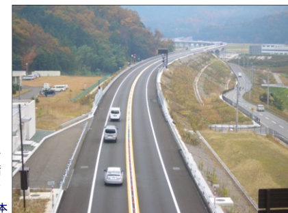
谷田部（やたべ）トンネル ～南川（みなみがわ）橋 (小浜IC(敦賀方向))を望む 提供：NEXCO西日本
