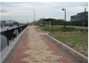
尼崎運河 遊歩道整備状況 提供: 兵庫県
