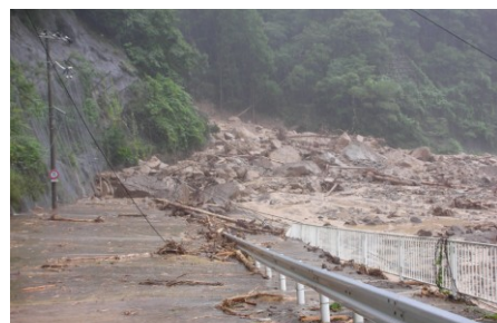
国道311号の土砂流出状況 (和歌山県田辺市中辺路町栗栖川)
