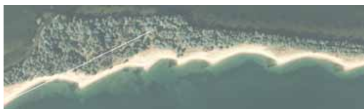
サンドバイパス施工中の天橋立 (H20)
