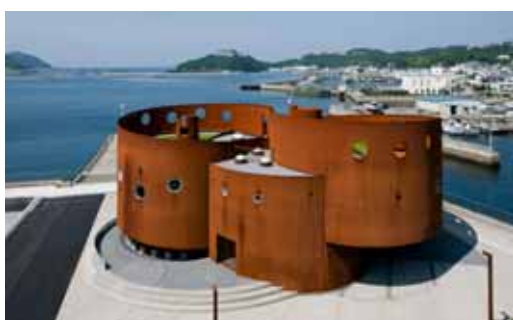
福良港津波防災ステーション 提供：兵庫県
