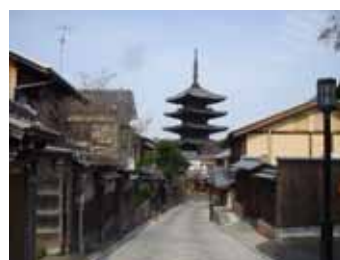
京町家の保全・再生などの取組 提供：京都市
