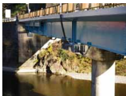
国道480号 橋梁耐震補強 谷口橋（有田川町） 提供：和歌山県
