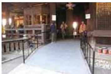
本堂横のスロープ 提供：近畿地方整備局
