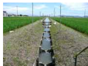
魚道設置による水田と排水路の落差解消
