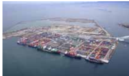
夢洲コンテナターミナル
