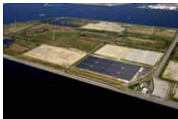
メガソーラー現地写真(H23.2) 提供:関西電力(株)
