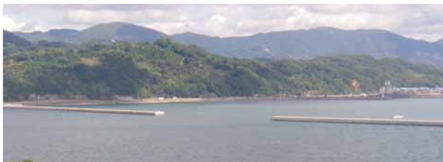
湯浅広港津波防波堤 (提供：和歌山県)
