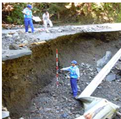
被災状況調査
