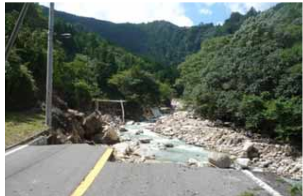
県道那智山勝浦線の道路崩落状況 （那智勝浦町川関～妙法山）
