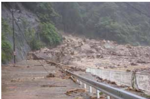
国道 311 号の土砂流出状況 （和歌山県田辺市中辺路町栗栖川）
