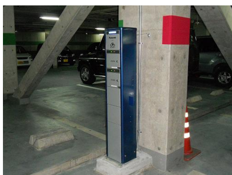
大津港駐車場に設置された普通充電設備
