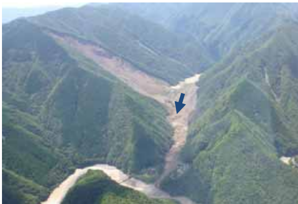
河道閉塞状況（奈良県五條市大塔町赤谷）
