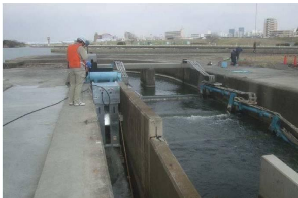
小水力発電設備
