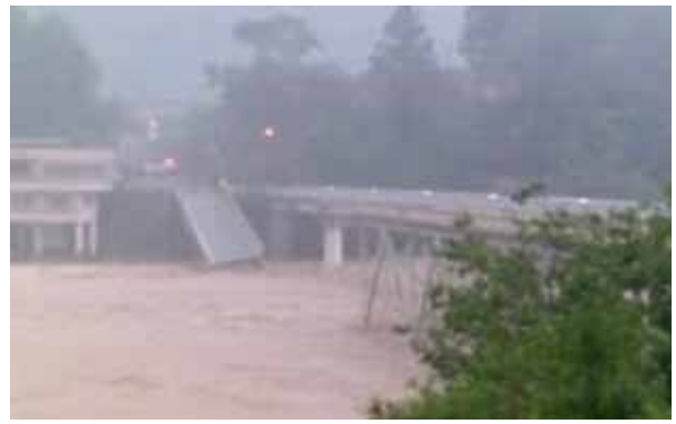
国道 168 号線落橋状況（奈良県十津川村折立） （提供：近畿地方整備局）
