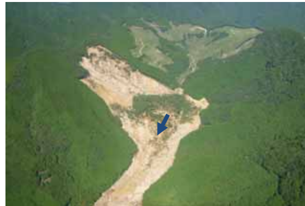
河道閉塞状況（和歌山県田辺市熊野） （提供：近畿地方整備局）
