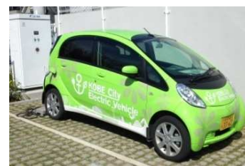
急速充電器の整備 提供：神戸市
