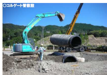
コルゲートパイプによる応急復旧 （提供：和歌山県）
