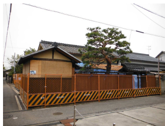
解体修理の様子 「辻番所他保存修理事業」 (提供：彦根市)
