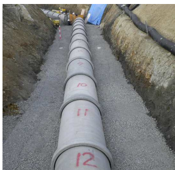
老朽化したパイプラインの更新工事中
