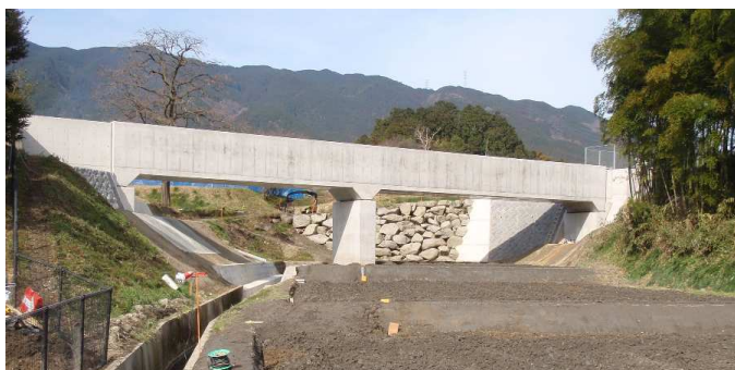
水路橋更新後
