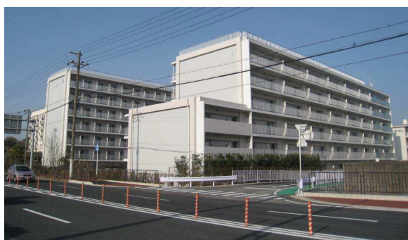
津波緊急避難ビル（海南合同宿舎）
