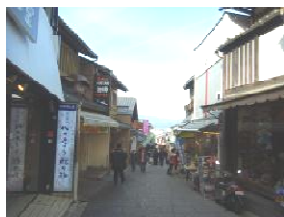
世界文化遺産清水寺周辺地区 (松原通)無電柱化事業 提供：京都市
