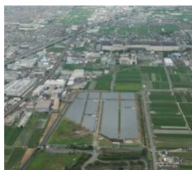
京都市水垂埋立処分地における大規模太陽光発電所 提供：京都市
