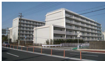
津波緊急避難ビルの指定(海南合同宿舎) 提供：近畿財務局
