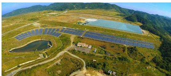
活用不能な法面を利用したコスモパーク加太太陽光発電所 提供：和歌山県
