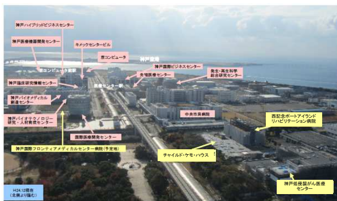
神戸医療産業都市（神戸市ポートアイランド）から神戸空港をのぞむ
