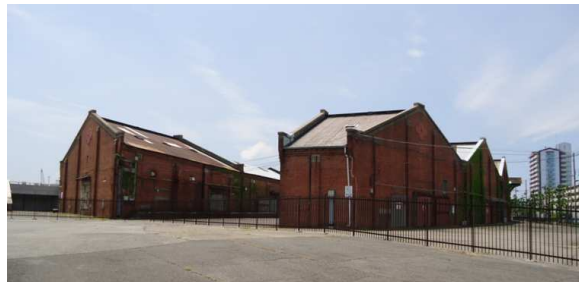
築港赤レンガ倉庫の集客拠点としての再生利用 提供：大阪市
