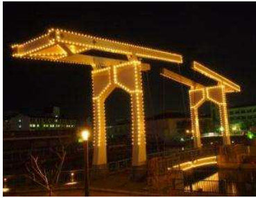
はね橋（橋名：はねっこ）の改修 提供：神戸市
