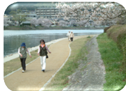
瀬田川の高水敷活用状況
