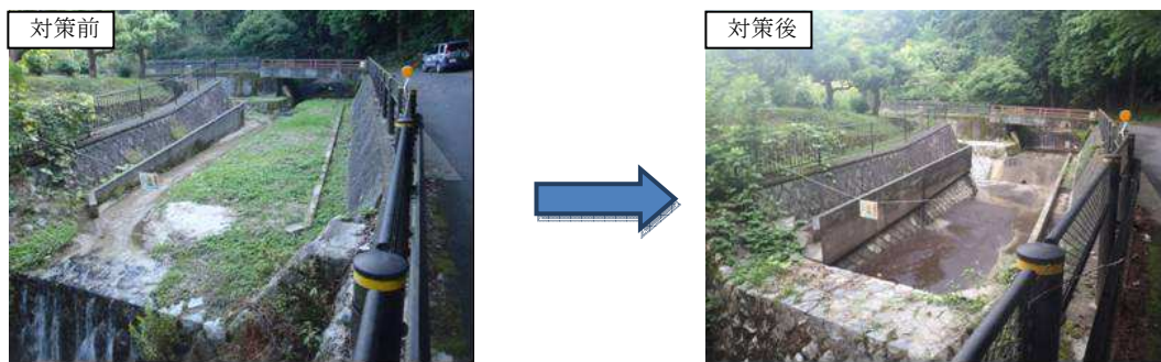
市民の暮らしを守る ～河川浸水対策緊急事業～ (浸水を未然に防ぐための浚渫(しゅんせつ))
