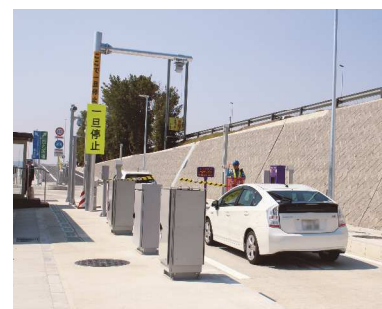
大和まほろばスマート IC（大阪側） 提供：奈良県
