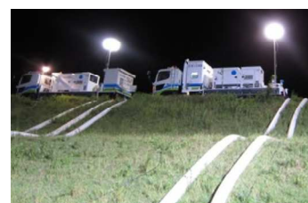
京都府等の台風第 18 号等による大雨被害時の 排水ポンプ車による緊急排水
