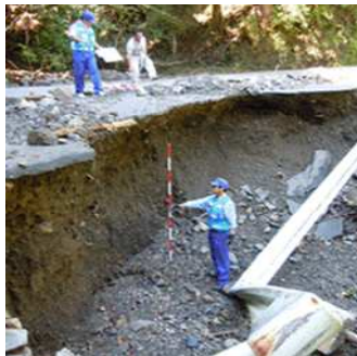
紀伊半島大水害時の被災状況調査 (大規模災害時における連携実績) 提供: 近畿地方整備局
