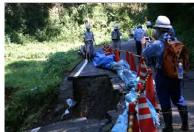
早期復旧に向けた調査 （舞鶴市白滝地区） 提供：近畿地方整備局
