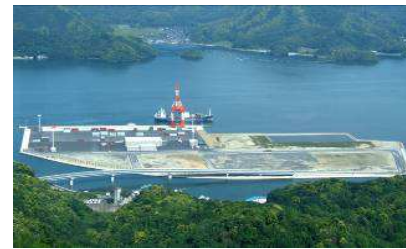
京都舞鶴港「舞鶴国際ふ頭」の供用 提供: 近畿地方整備局
