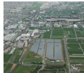
京都市水垂埋立処分地における大規模太陽光発電所 (埋立地・企業団地を利用したメガソーラーの設置・運転開始) 提供:京都市
