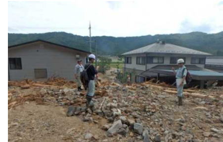
土石流被害状況(丹波市)
