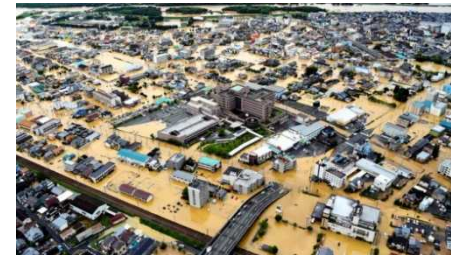
内水被害状況(福知山市)
