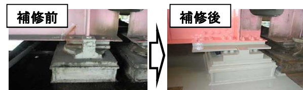
橋梁補修による延命化
