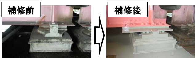
橋梁補修による延命化
