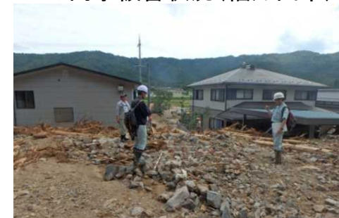
土石流被害状況(丹波市)
