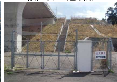
近畿自動車道紀勢線に設置された避難階段
