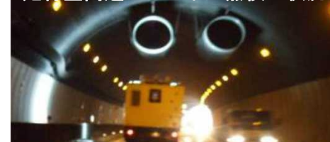
走行型高速3Dトンネル点検の状況
