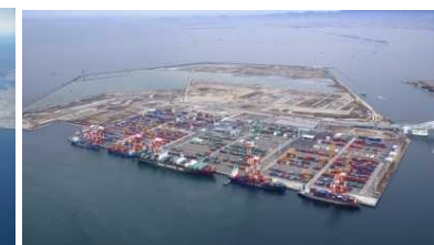
コンテナターミナル(大阪港)
