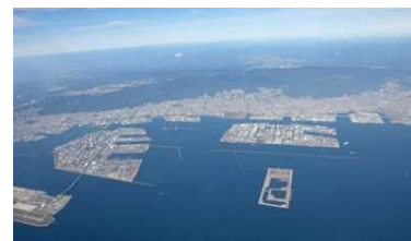
コンテナターミナル(神戸港)
