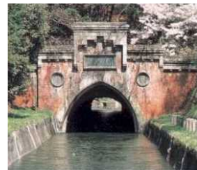
琵琶湖疏水 (第1疏水第2トンネル西口) 出典:京都市
