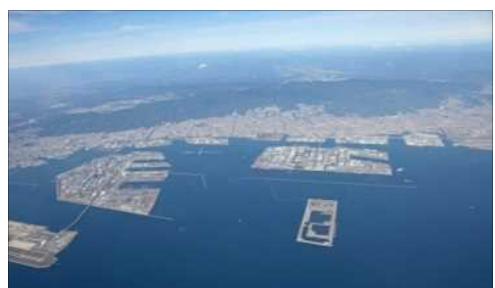
コンテナターミナル(神戸港)
