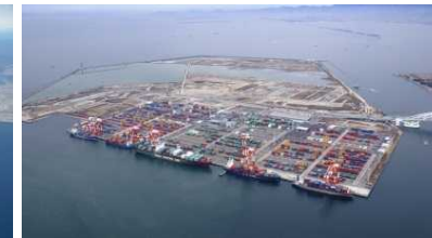
コンテナターミナル(大阪港)
