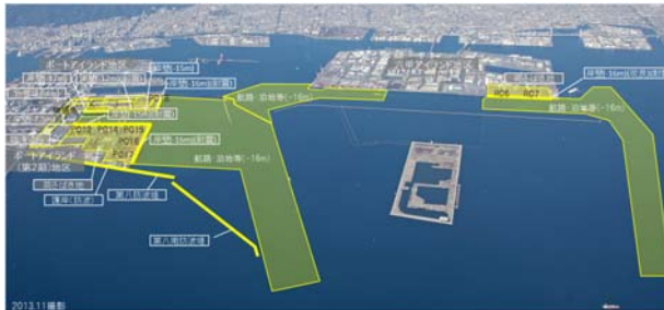
神戸港国際海上コンテナターミナル整備事業の概要 提供:近畿地方整備局
