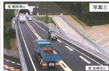
京奈和自動車道の開通後の状況 提供:近畿地方整備局
