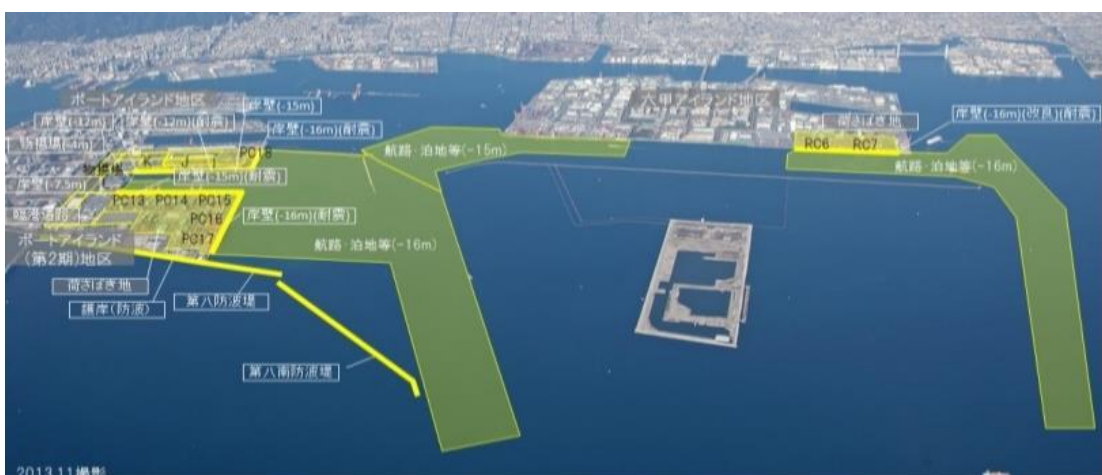
神戸港国際海上コンテナターミナル整備事業の概要 提供：近畿地方整備局
