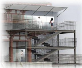
素屋根と見学デッキ
