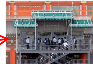
南門素屋根施設南面に実物大の南門を描いたメッシュシートを設置
