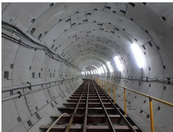
守口調整池のシールド工事概成 提供：大阪府
