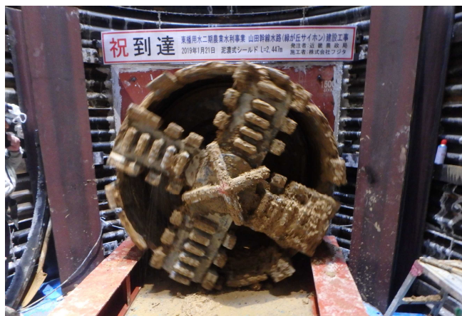
山田幹線水路付け替え工事の完成 提供：近畿農政局
