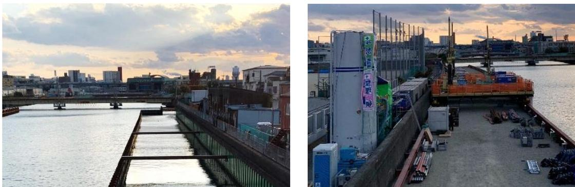
六軒家川防潮堤の液状化対策（左：鋼矢板打設／右：地盤改良工）
