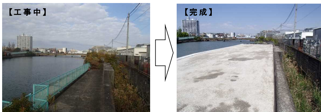
六軒家川防潮堤の液状化対策
