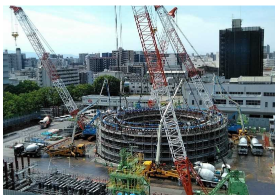
寝屋川北部地下河川 城北立坑増築工事
