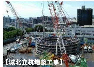
【城北立坑増築工事】
