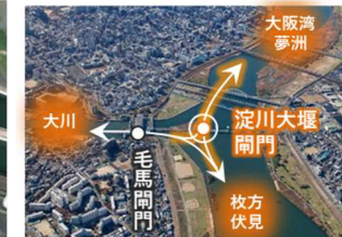
閘門設置後の淀川大堰周辺
