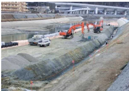
出在家地区河道掘削(猪名川)
