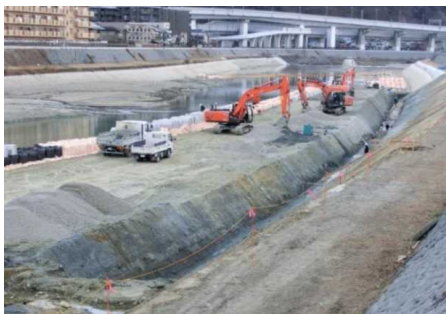
出在家地区河道掘削(猪名川)
