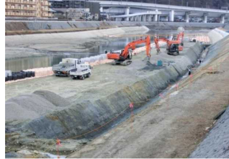
出在家地区河道掘削(猪名川)
