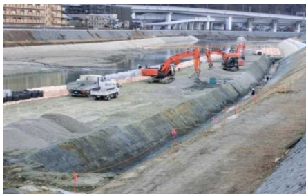
出在家地区河道掘削(猪名川)
