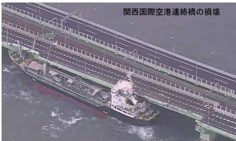
2018年9月 台風第21号による風被害
