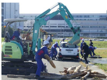
道路啓開訓練
