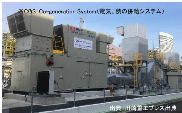
※CGS: Co-generation System (電気、熱の併給システム)
