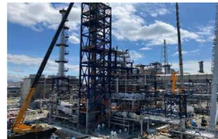
建設風景(2024年6月21日撮影)
