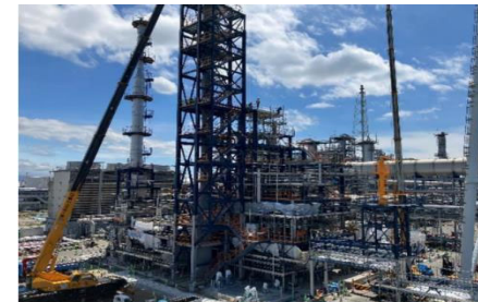
建設風景(2024年6月21日撮影) 出典：第5回 持続可能な航空燃料(SAF)の導入促進に向けた官民協議会 資料5 コスモ石油提供資料
