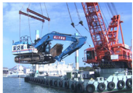
起重機船によるバックホウ吊り上げ訓練
