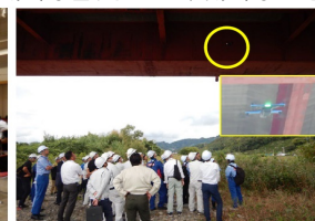
360度周囲を認識するフローンをを用いた橋梁点検支援技術
