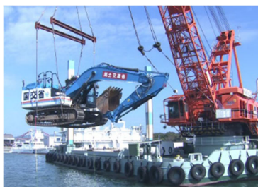
起重機船によるバックホウ 吊り上げ訓練
