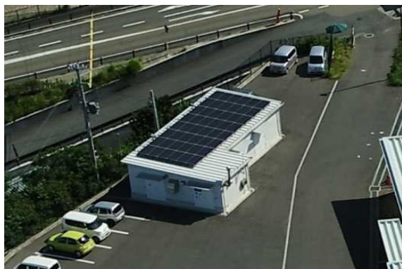
道の駅「すさみ」の太陽光パネル
