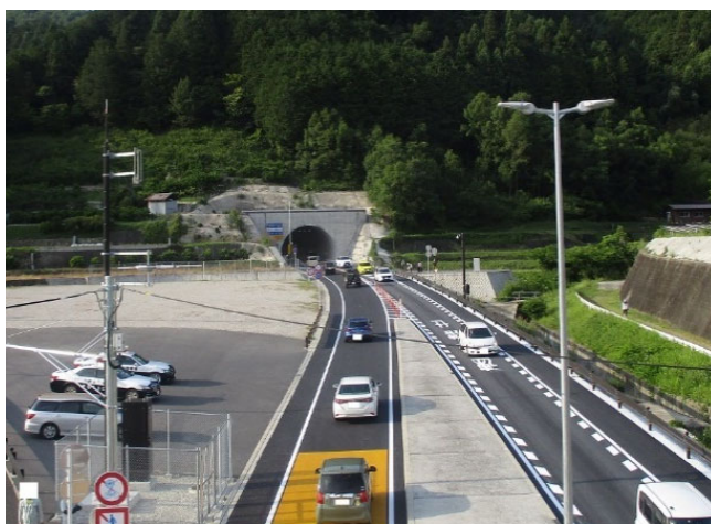
天見紀見トンネル
