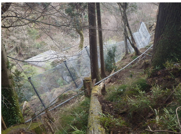
落石防護柵工（斜面对策）
