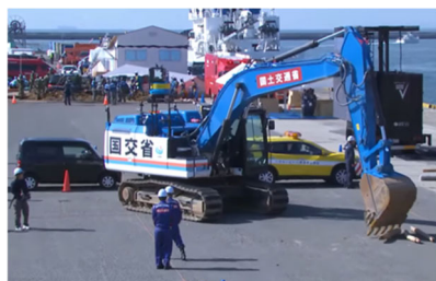
広域陸路確保訓練 (遠隔バックホウ使用)
