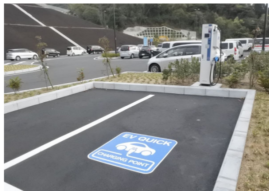
道の駅「みさき」のEV充電施設
