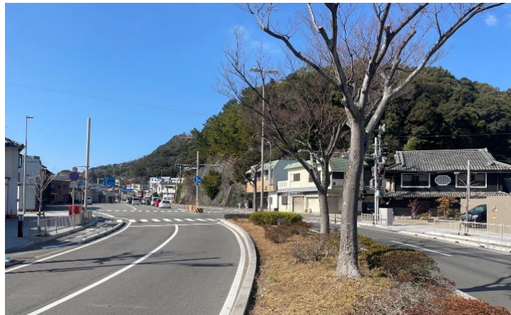
無電柱化による市街地の良好な景観形成
