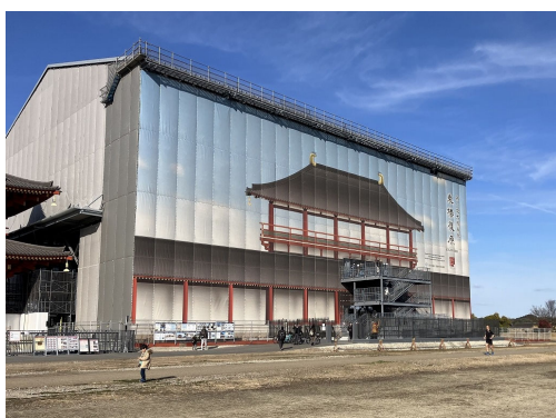
素屋根と見学デッキ全景
