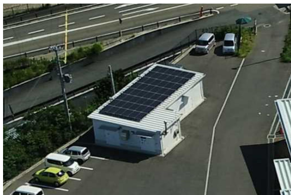
道の駅「すさみ」の太陽光パネル
