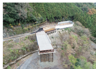
新天辻工区（奈良県）
