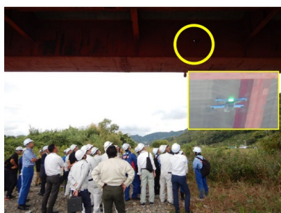
360度周囲を認識するドローンを用いた橋梁点検支援技術
