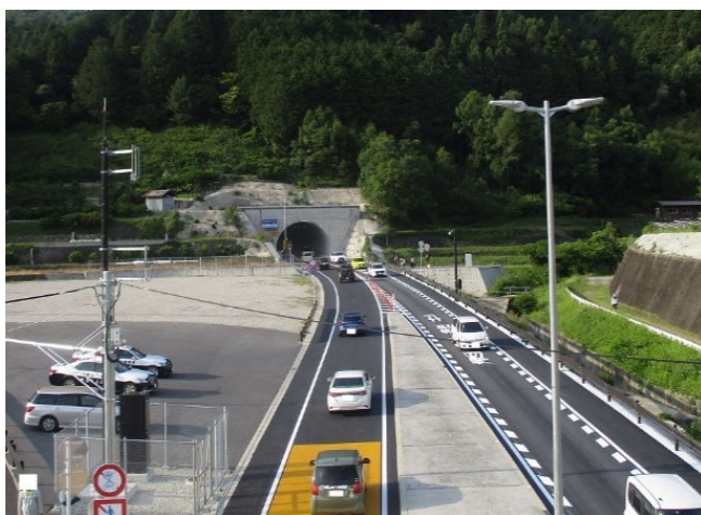
天見紀見トンネル
