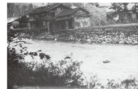
旧大野郡和泉村板倉付近（写真出典：九頭竜川流域誌） 九頭竜川右岸の深淵により、崩れ落ちそうな民家。
