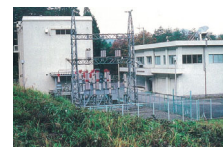
真名川発電所
