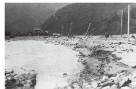
旧大野郡和泉村朝日付近（写真出典：九頭竜川流域誌） 九頭竜川右岸が決壊し、国道159号を跡形もない程に押し流しました。（電柱の立っている場所が元国道）
