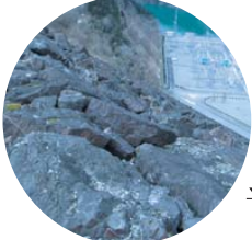
ロックフィルダム 表面が大きな岩で覆われています。
