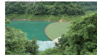
可動式汚濁防止フェンスを設置
