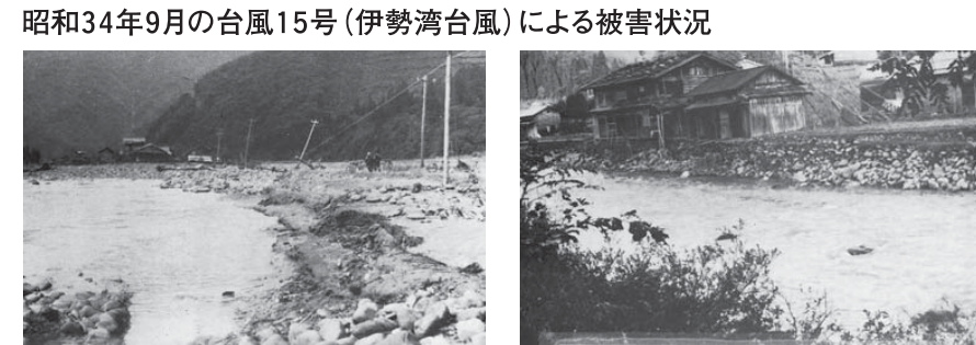
旧大野郡和泉村朝日付近(写真出典：九頭竜川流域誌) 九頭竜川右岸が決壊し、国道158号を跡形もない程に押し流しました。(電柱の立っている場所が元国道) 旧大野郡和泉村板倉付近(写真出典：九頭竜川流域誌) 九頭竜川右岸の深掘により、崩れ落ちそうな民家。
