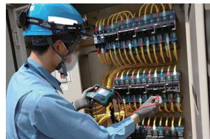
電気設備の点検状況
