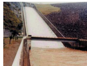
九頭竜ダム ダム放流状況 (S51.9 台風17号)
