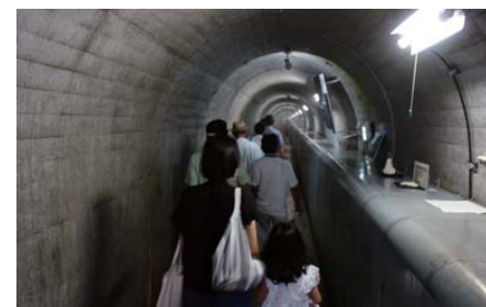
真名川ダム見学 (連絡通路)
