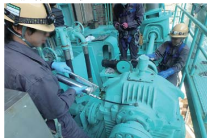
ダム放流設備の点検状況
