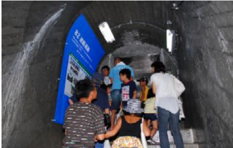
ダム内部の通路
