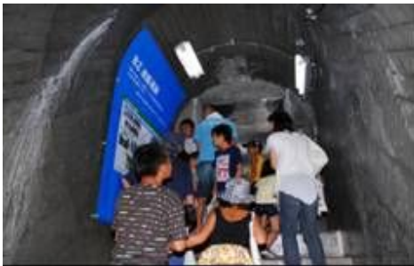
ダム内部の通路
