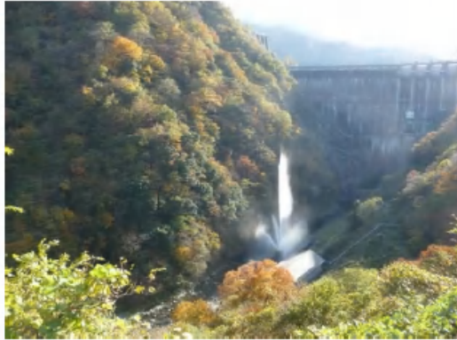
真名川ダム下流部
