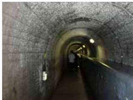
ダム内部の通路
